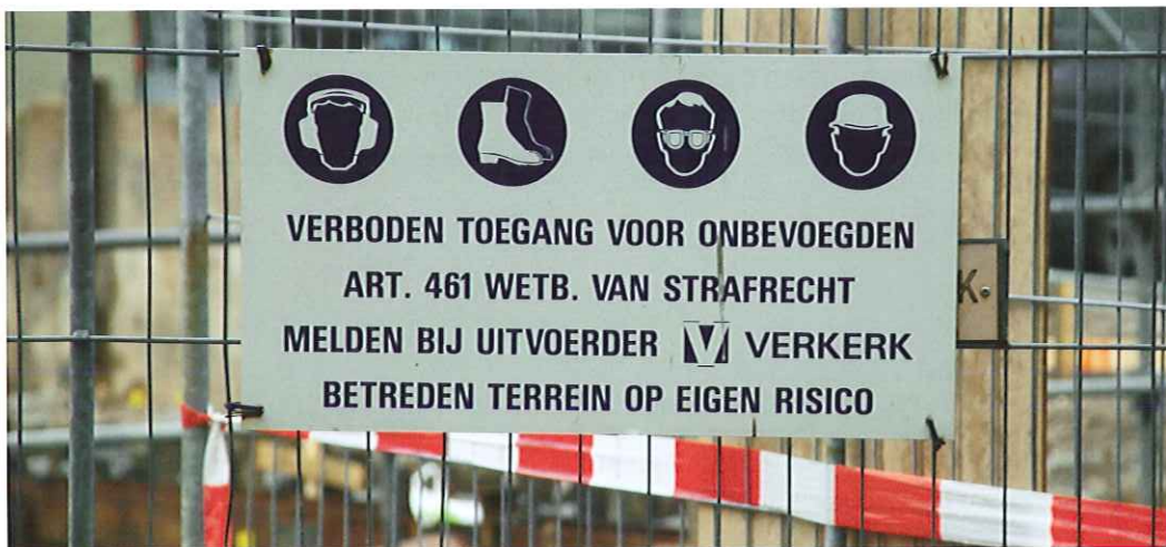
Gebodsborden op de omheining van een bouwterrein gelden voor het gehele terrein.
